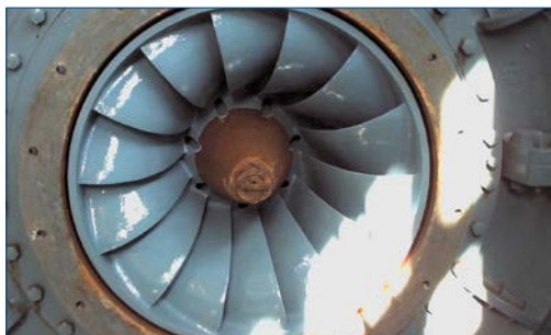
Отремонтированное рабочее колесо установлено на место и готово к работе
