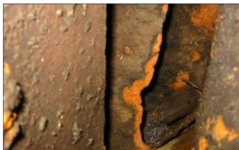
Рис. 2: Разрушенное рабочее колесо турбины
