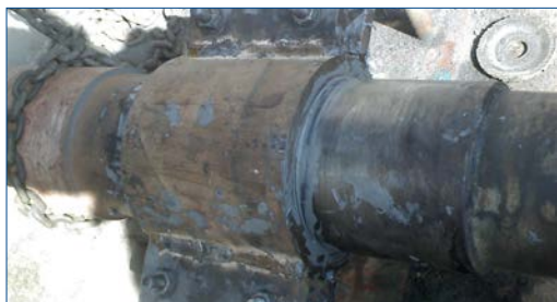
Нанесен материал Belzona, установлен формер
