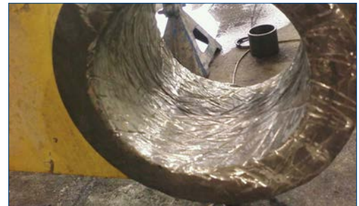
Подготовка поверхности завершена
