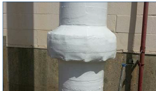
Фланцевое соединение в защитной оболочке
