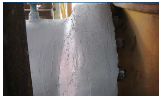
Применение Belzona 1161 (Super UW-Metal) для герметизации фланца
