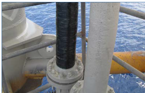
Система Belzona SuperWrap II в завершеном виде
