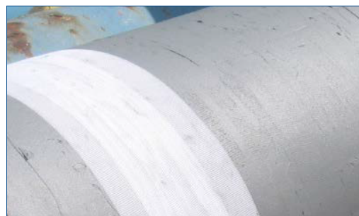
Завершение ремонта с использованием Belzona 1161 (Super UW-Metal)
