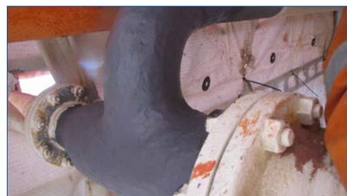
Композитный ремонт тройника
