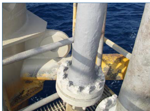
Коррозионные повреждения заполнены и восстановлена толщина стенок
